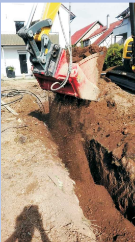
zum Schutz des Kollektorrohres werden grobe Steine aussortiert
