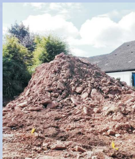
zum Schutz des Kollektorrohres werden grobe Steine aussortiert
